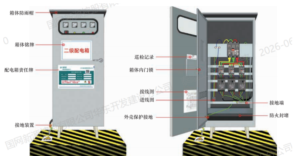
图 1 传统二级施工电源柜示例图
